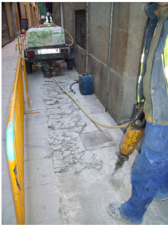
Vista de l'extracció del paviment de lloses.
