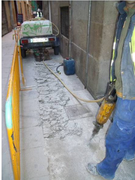
Foto 1: Vista de l'extracció del paviment de lloses.
