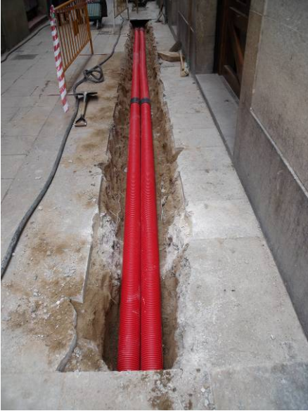
Foto 3: Vista de la rasa un cop posats els tubs.
