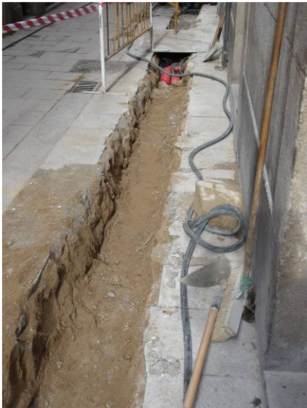
Foto 2: Vista de la rasa un cop excavada.
