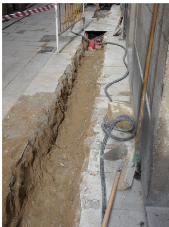
Vista de la rasa un cop excavada.
